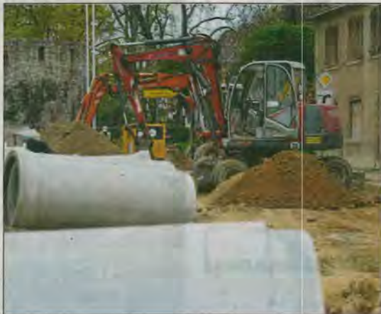
Die Burgstraße steht derzeit im Mittelpunkt der Arbeiten in Schkölen.
